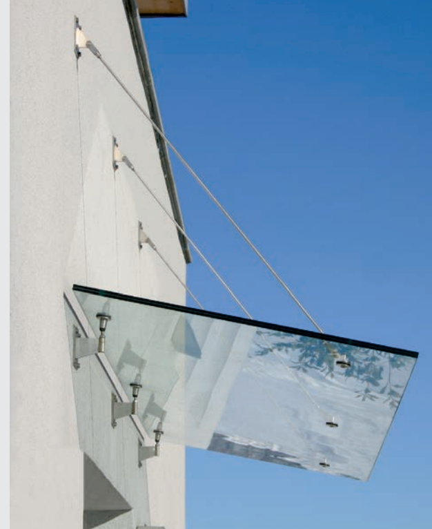
Glashaltesystem für Vordächer aus Glas
