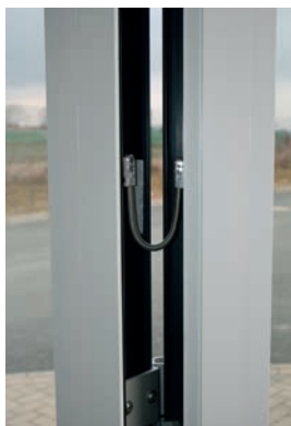
Abb. 10.32: Kabelführung Rahmen – Flügel
