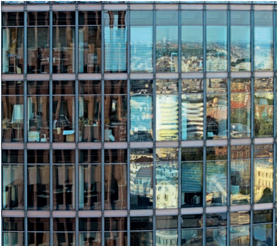
Abb. 3.31: Isolierglas-Effekt
